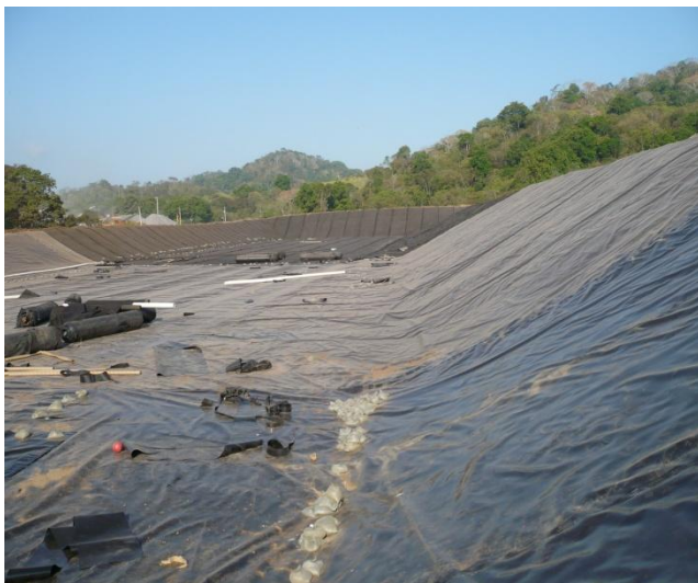
DURANTE LA CONSTRUCCIÓN
