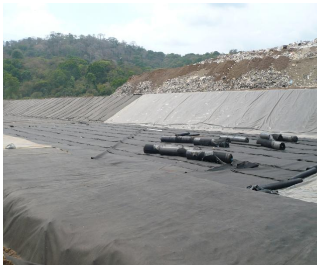
DURANTE LA CONSTRUCCIÓN
