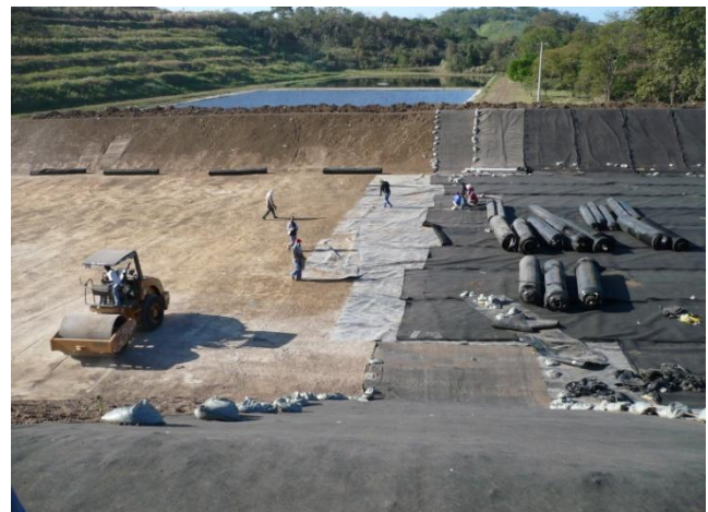
DURANTE LA CONSTRUCCIÓN
