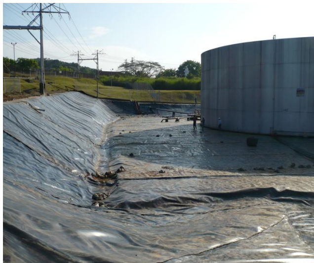
DURANTE LA CONSTRUCCIÓN
