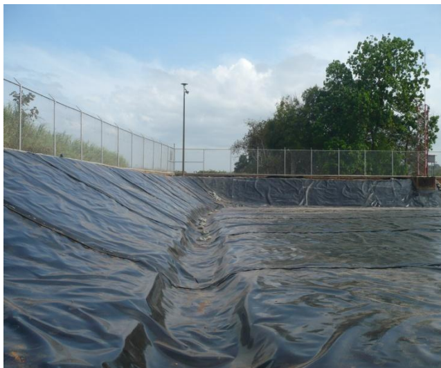
DURANTE LA CONSTRUCCIÓN
