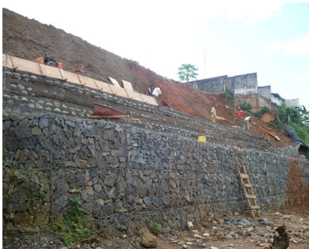
DURANTE LA CONSTRUCCIÓN
