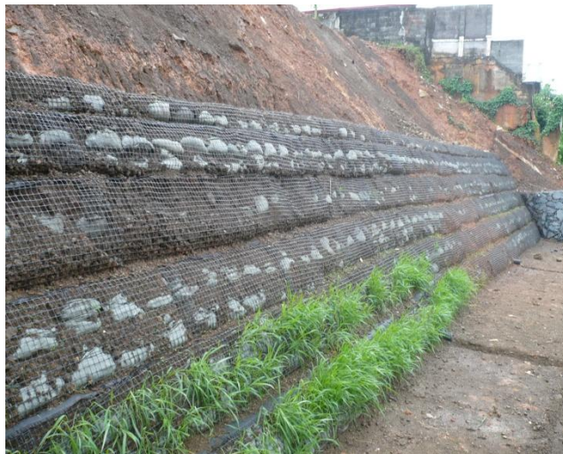
DURANTE LA CONSTRUCCIÓN
