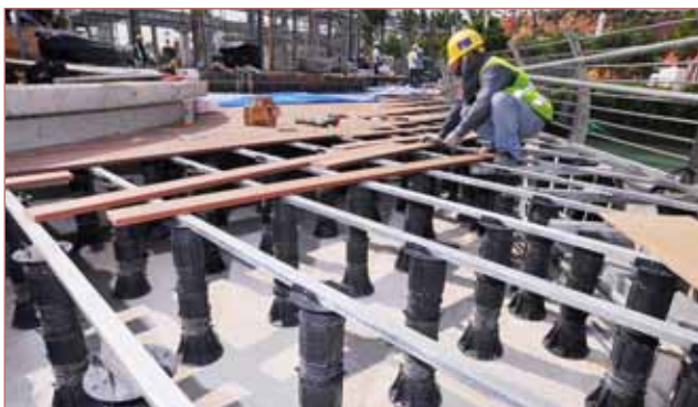
VersiJack® proporciona un apoyo estable para la instalación de terrazas de madera.
