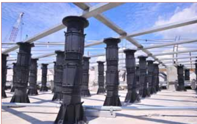
VersiJack® permite un fácil acceso a la capa impermeable para hacer mantenimiento cuando sea necesario.
