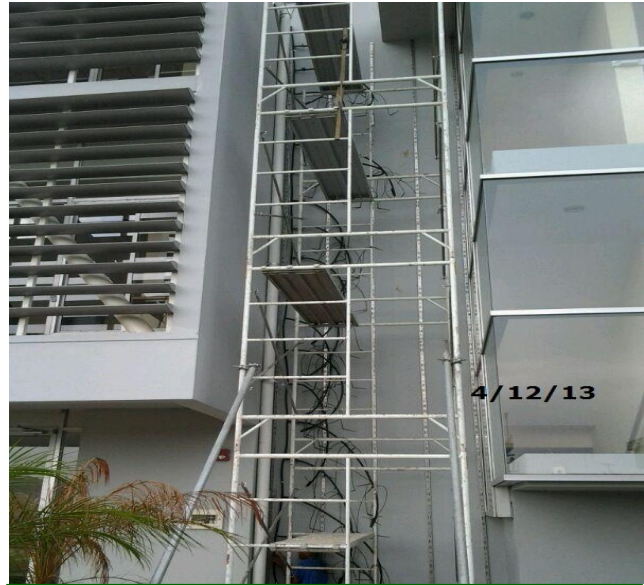
INSTALACION Y PRUEBA DEL SISTEMA DE RIEGO
