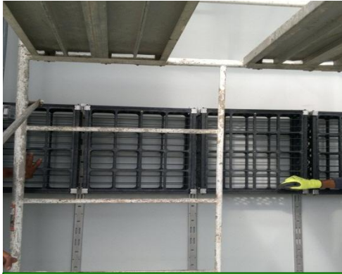
PRIMER PASO-POSICIONAMIENTO CORRECTO DE MODULOS Y RIELES EN LA PARED
