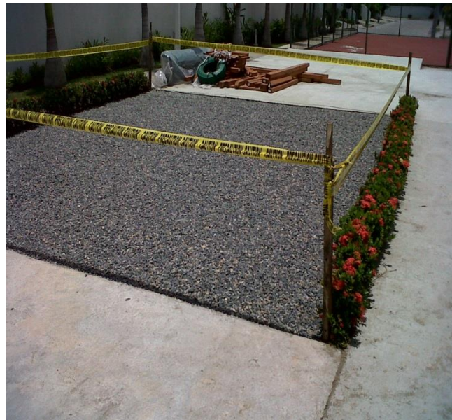
2. AREA LISTA PARA INSTALACION DE GRAMA ARTIFICIAL
