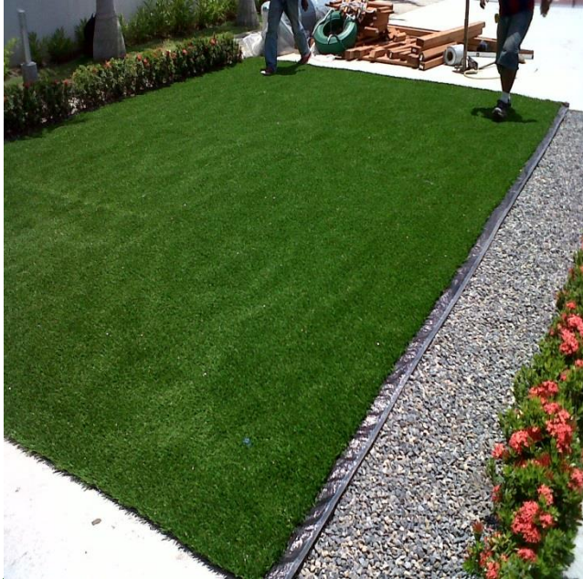
3. INSTALACION DE GRAMA ARTIFICIAL
