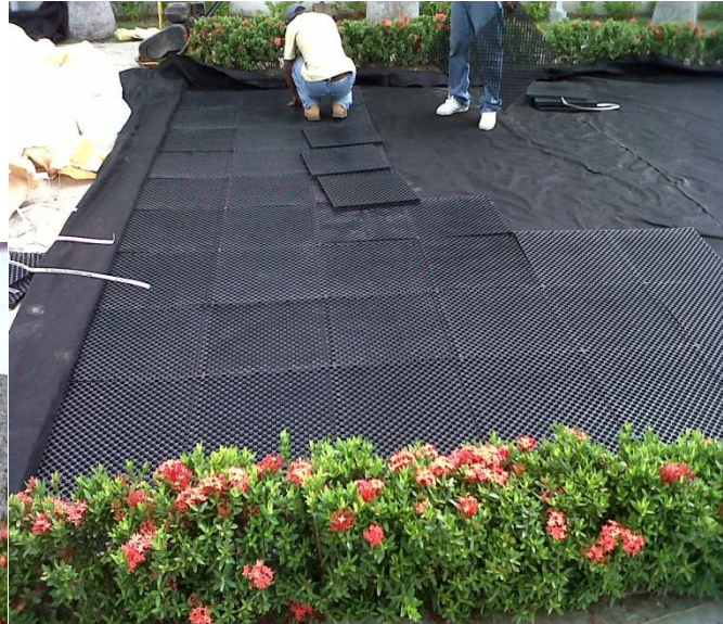
1. GEOTEX Y MODULOS DE VERSICELL DE 50CM X 50CM SE INTERCONECTAN POR MEDIO DE INSERTOS QUE TIENEN EN 2 DE SUS LADOS CREANDO UNA SUPERFICIE A NIVEL
