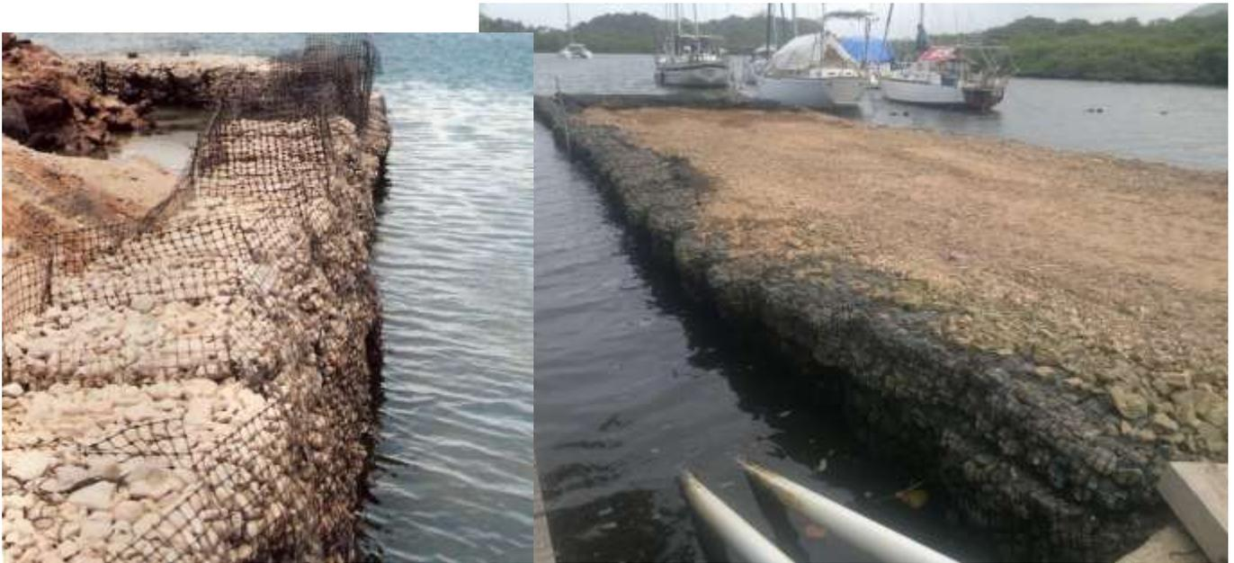
**PROYECTO: MURO DE GAVIONES Y COLCHONES GEOMALLA BIAxIAL. PUNTA BARCO.**
