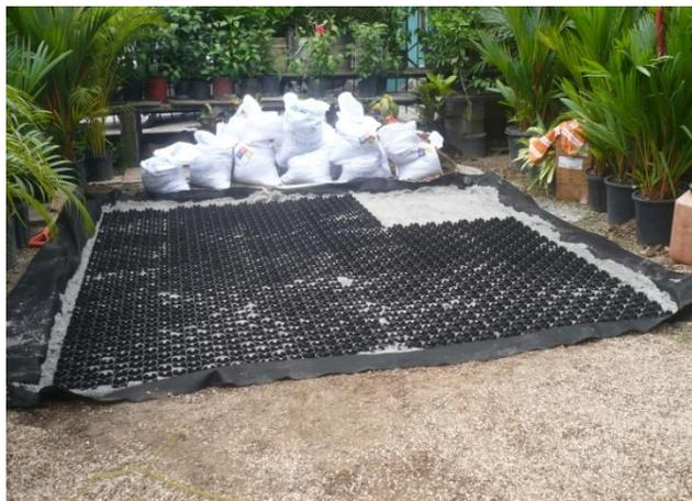
2- REMUEVE UN ESPESOR DE 6 CM DE TIERRA COLOCA UN GEOTEXTIL SEPARADOR, ARENA PARA NIVELAR E INSTALA EL TURPAVE
