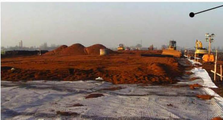
La construcción de 14 KM de nuevas vías dobles sobre terreno pantanoso siempre requirió el uso de alguna forma de capa geosintética para suministrarle al cliente la solución de diseño óptimo.
