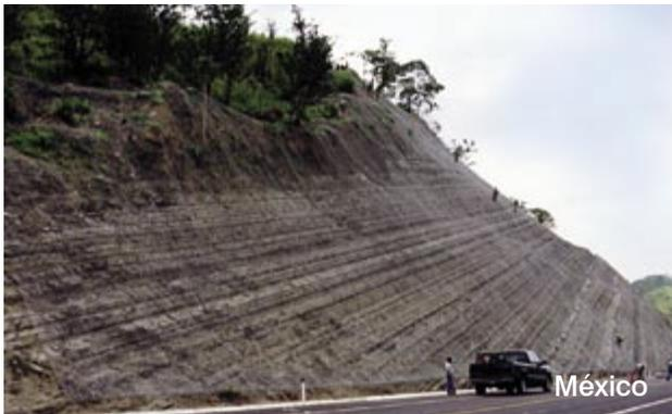
Las torsiones de la malla hexagonal garantizan que éstas, ante un eventual corte o rotura de los alambres por tracción, impacto u otros, no se desteja, manteniendo así la eficiencia de la solución.
