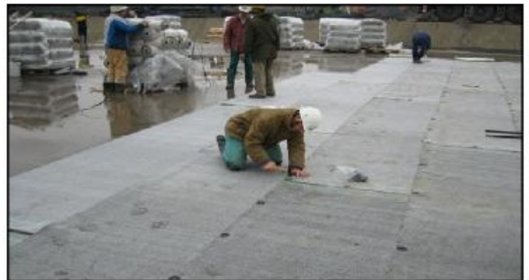
Instalación en Losas
