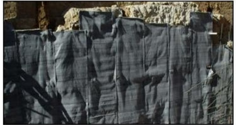
Instalación contra Terreno
