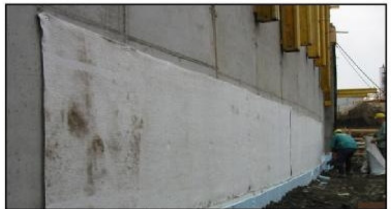
Instalación en Muros de Concreto
