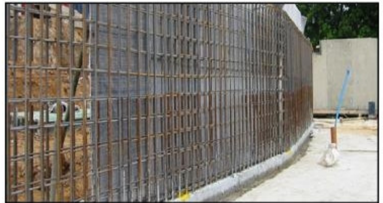
Instalación en Encofrado de Madera
