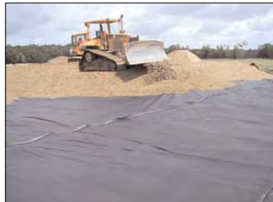
Fig 3.- Gracias a la resistencia a la tracción de los tejidos pueden realizarse consolidaciones de pendientes de gran inclinación.
